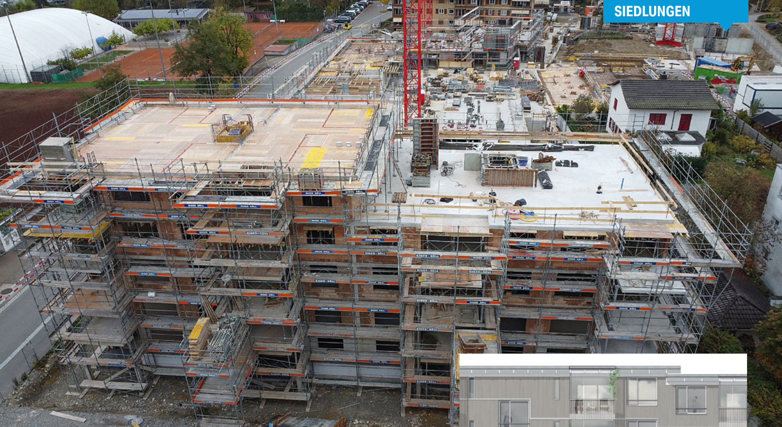
Im Vordergrund der Rohbau des Gebäudes an der Grubenstrasse.
