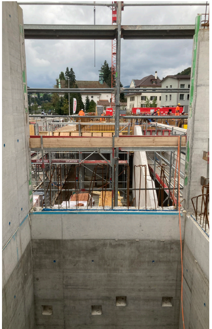
Der Liftschacht mit den ausgesparten Löchern.
