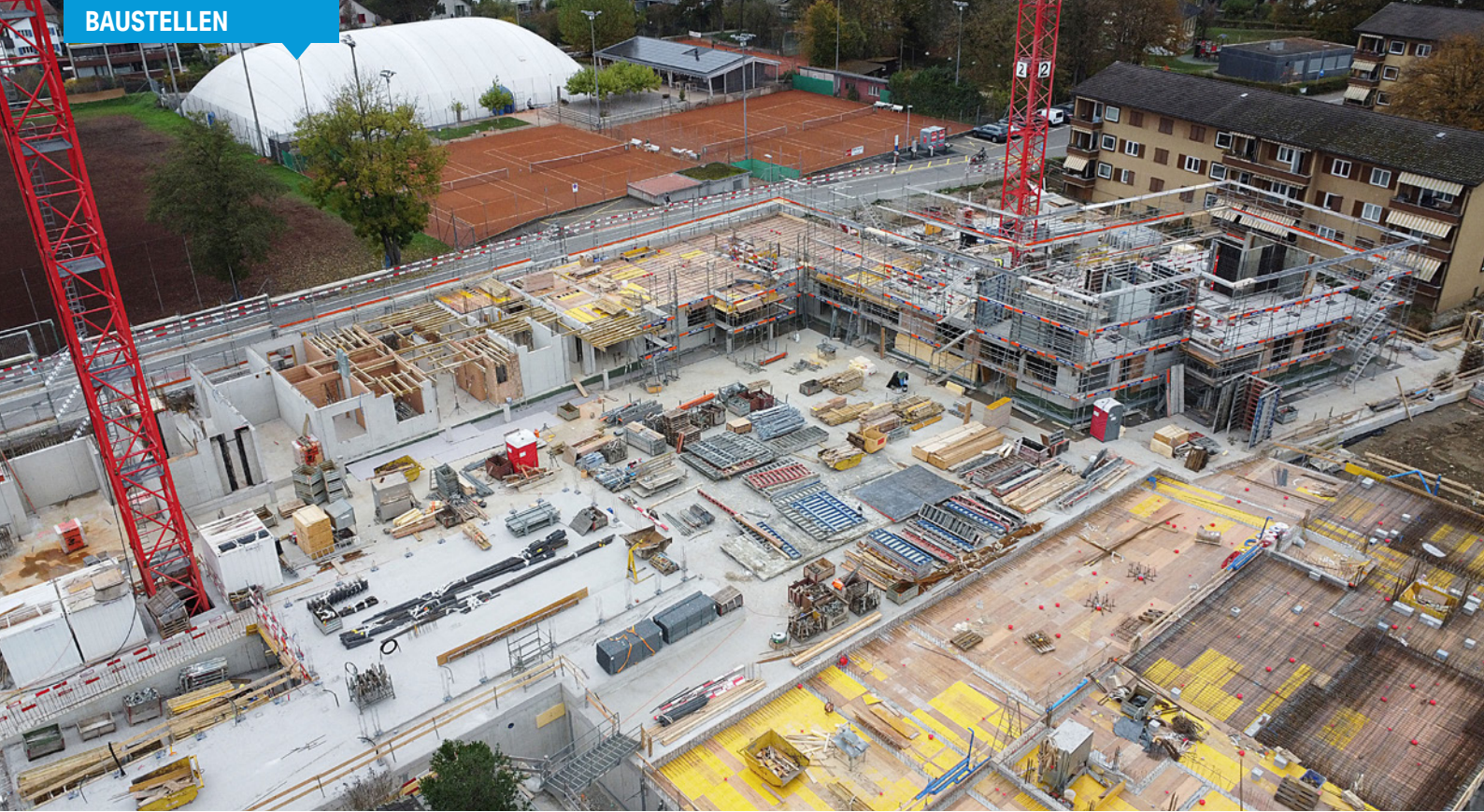
Blick auf die Baustelle Klosterbrühl.
